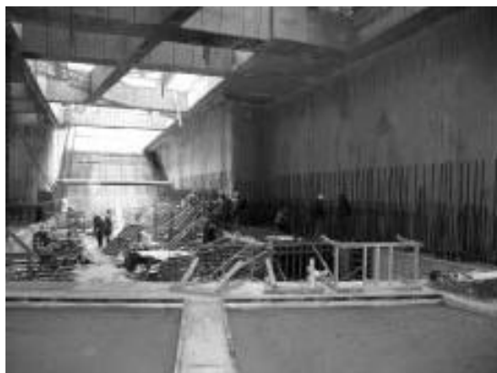
Vasbeton szerelés a Fővám téri állomáson
