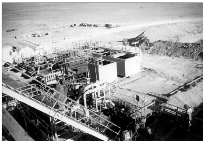
A RIG-3 iszaprendszer, tartályai
