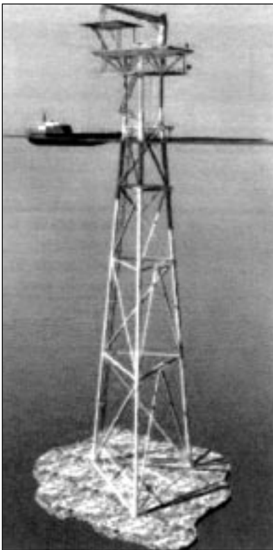
4. ábra: Felszerelt kezelő nélküli kútfejfedélzet
