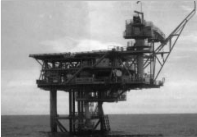
4. ábra: Felszerelt kezelő nélküli kútfejfedélzet
