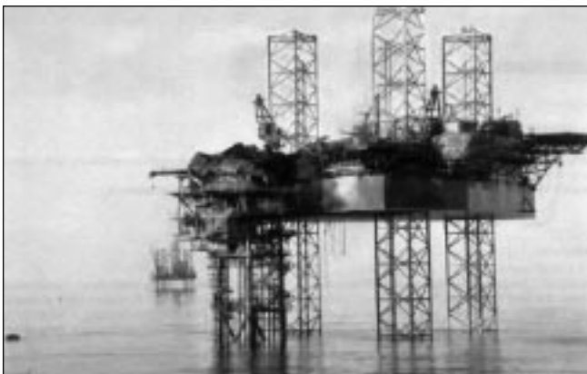
1. ábra: Leégett kezelő nélküli kútfejfedélzet és a lábakra emelhető fűrófedélzet
